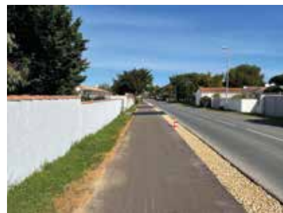
Travaux en cours sur la piste cyclable.
