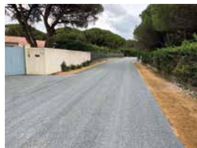
Travaux en cours sur la route de la Patache.
