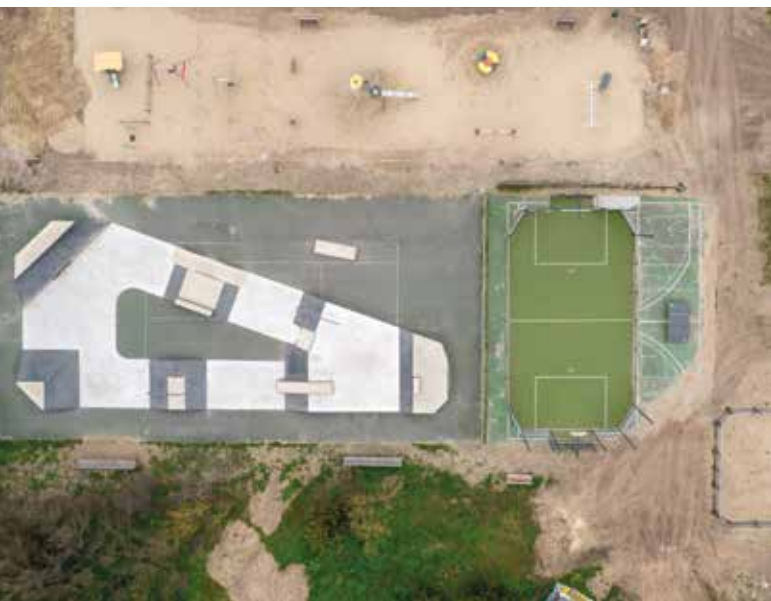
Les travaux en cours sur l'aire du Gros Jonc.
